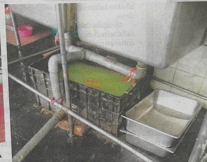
Keadaan restoran yang kotor kerana tidak menggunakan perangkap gris seperti disyaratkan PBT.
